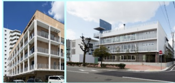
西宮市こども未来センター 平成27年竣工
