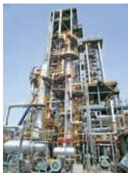
石油製品精製プラントの全景
