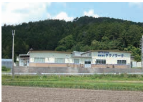
本社工場全景
