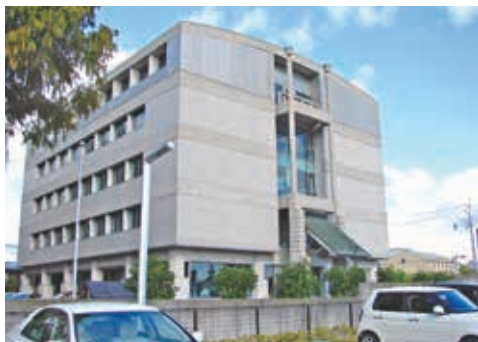
たつの市にある本社ビル
