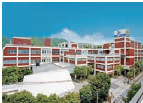
第1工場・第2工場に分かれた全景
