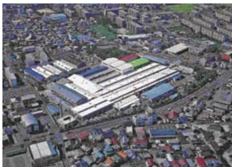
本社工場の敷地面積は東京ドーム約1個分の広さです
