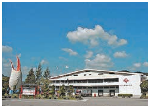
駐車場から見た工場
