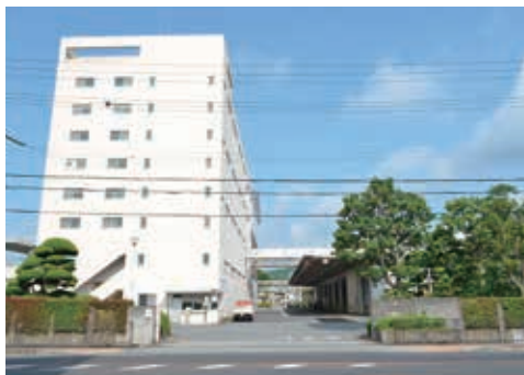
ヒガシマル醤油 第一工場正門
