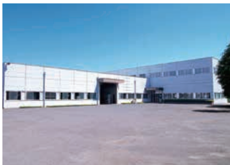
平成26年 一貫生産のため拡張した淡路工場
