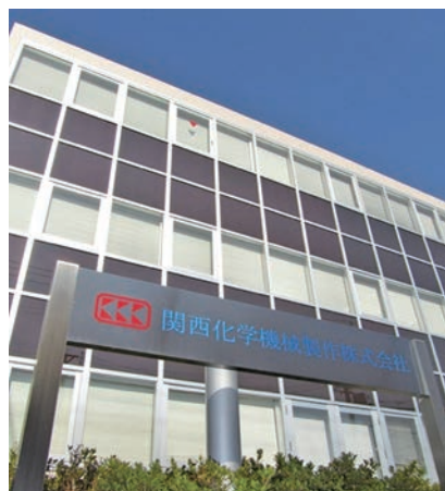
本社管理棟：太陽光発電を壁に施工して省エネ
