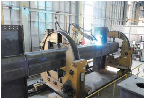
鉄骨の柱をロボットにて溶接中
