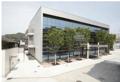
本部事務所 平成23年11月竣工
