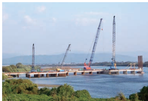
作業用構台架設(リーブラ工法)
