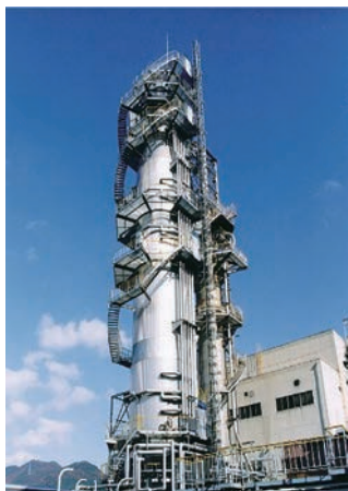
原材料の木材チップを炊く釜です
