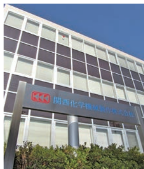
本社管理棟:太陽光発電を壁に施工して省エネ
