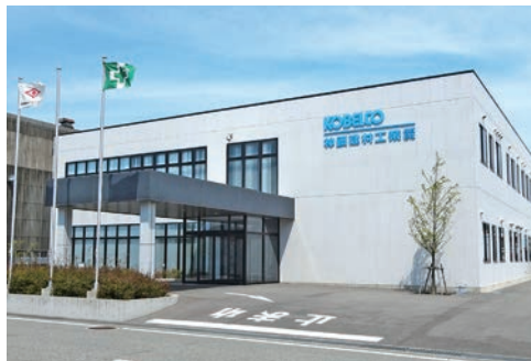
2013年5月 本社所在地内に新社屋が竣工
