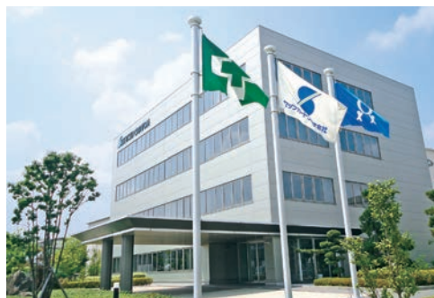
セツツカートン(株) 本社および伊丹工場事務所棟
