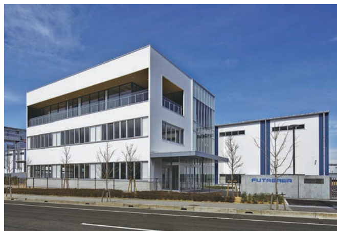
2019年に新設した神戸工場
