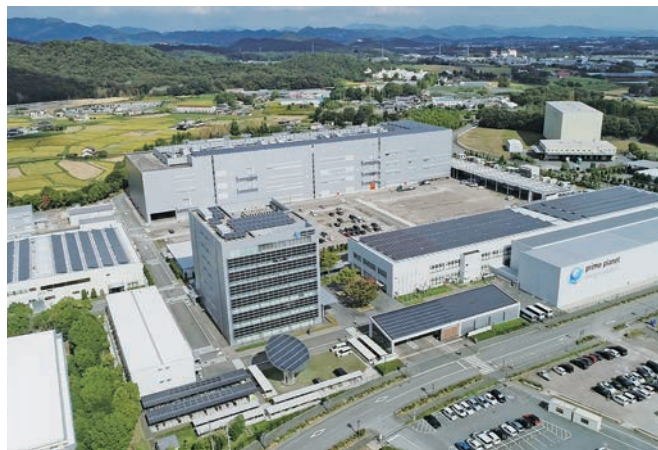
関西本社 加西工場
