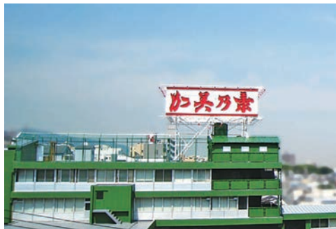
神戸市中央区にある本社工場
