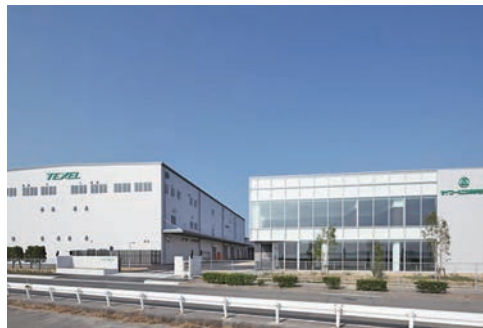
明石本社・本社工場
