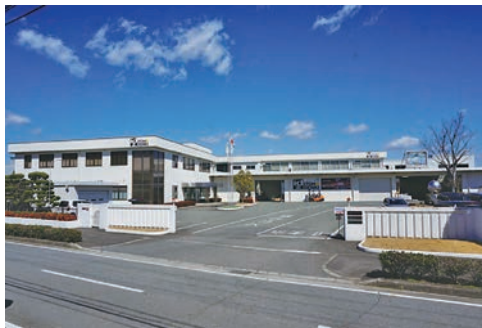
本社第一工場
