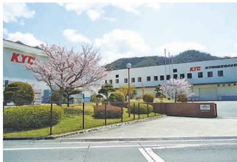
西脇工場(第一・第二) 2005年6月移転操業
