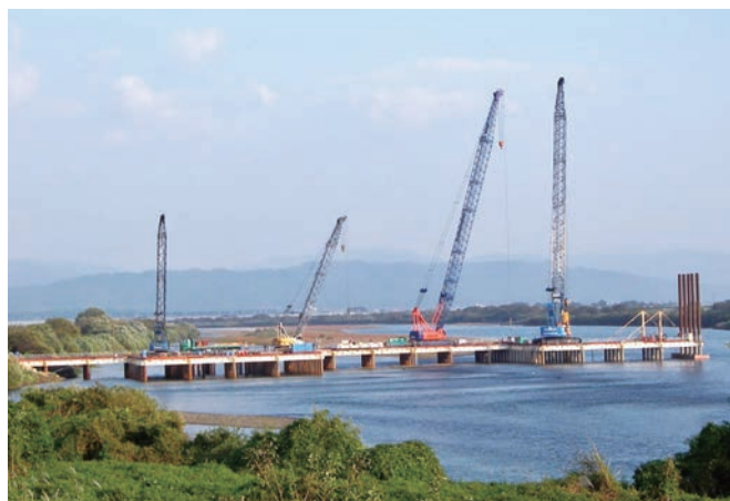
作業用構台架設（リーブラ工法）
