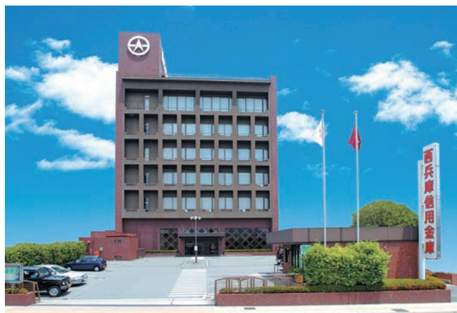
宍粟市山崎町にある本店建物
