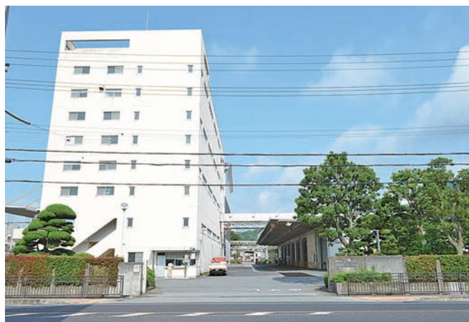
ヒガシマル醤油 第一工場正門
