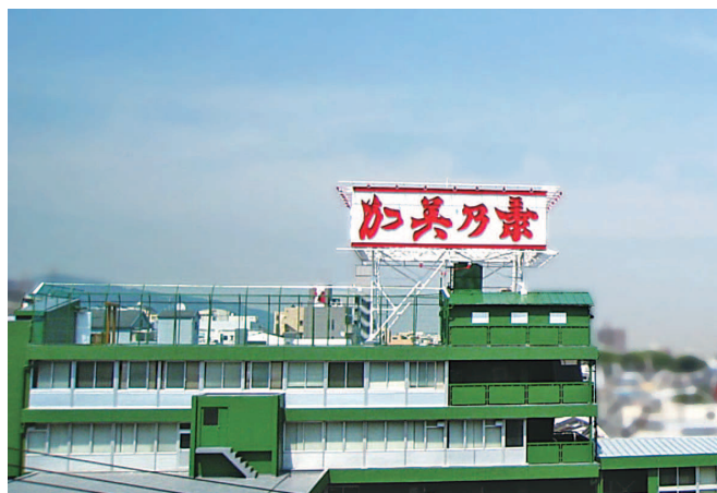
神戸市中央区にある本社工場
