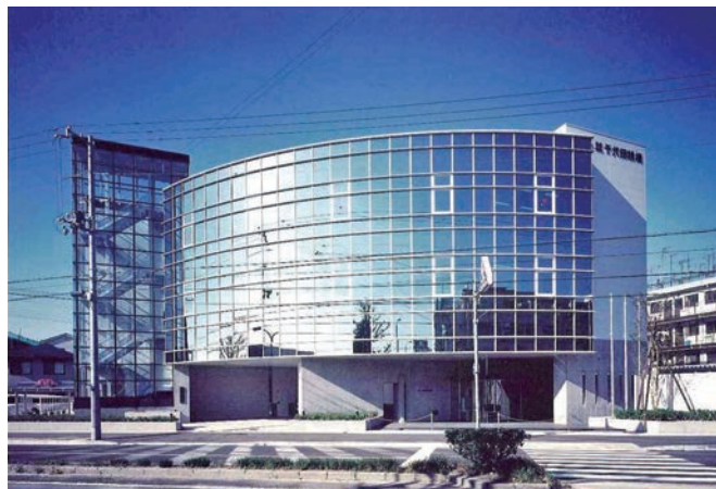
神戸市長田区に構える本社ビル
