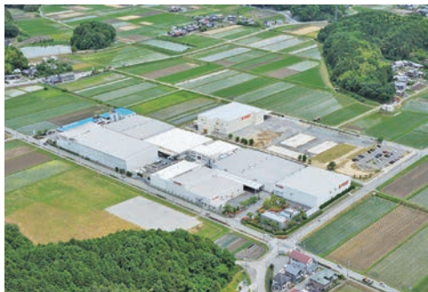
篠山市にある本社工場全景
