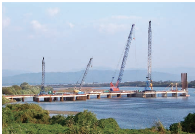
作業用構台架設（リーブラ工法）
