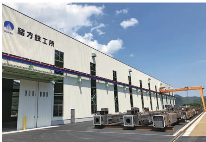
新設した第二工場です
