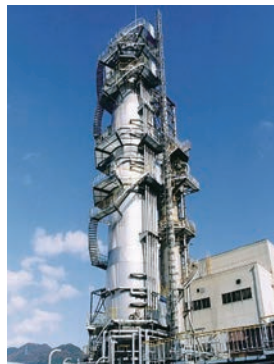
原材料の木材チップを炊く釜です
