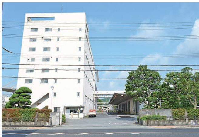
ヒガシマル醤油 第一工場正門
