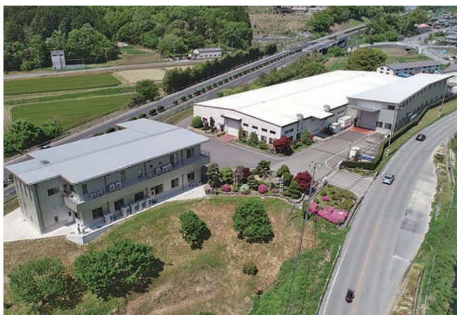
緑に囲まれた好環境の中に、3つの工場があります
