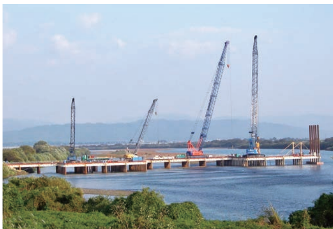
作業用構台架設 (リーブラ工法)
