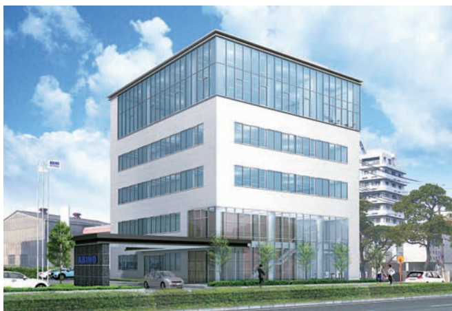
阿比野建設本社事務所
