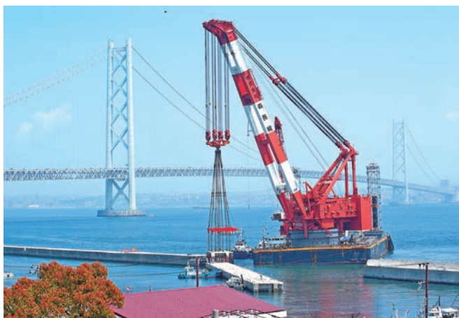
岩屋港にて防波堤工事に従事する第一豊号
