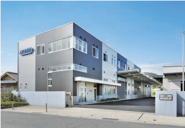
難易度の高い砂型を製造している第二工場
