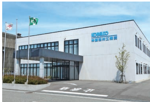
2013年5月 本社所在地内に新社屋が竣工
