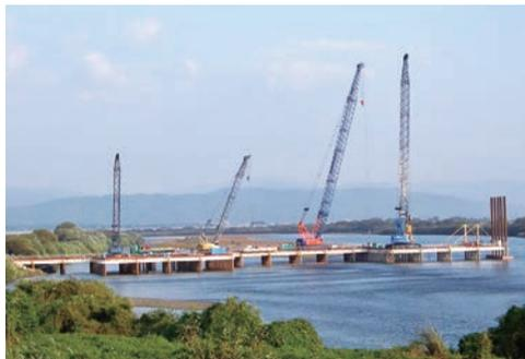
作業用構台架設(リーフラ工法)
