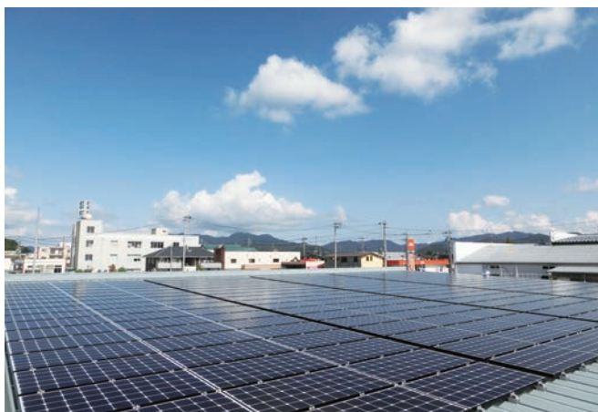
人が「働く」環境において、様々な分野の改善をサポート!
